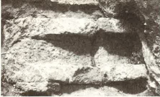
Camaret sur Aigues, conduite de l'aqueduc antique
